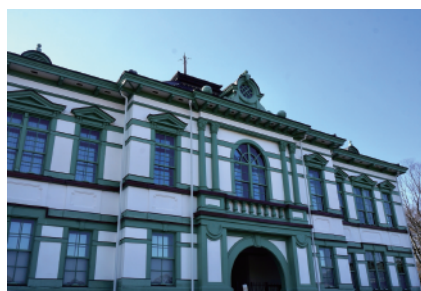
国立工芸館 木造の旧陸軍施設を移築活用した、近現代の工芸・デザインを専門とする美術館。 2020 年 10 月移転開館。
